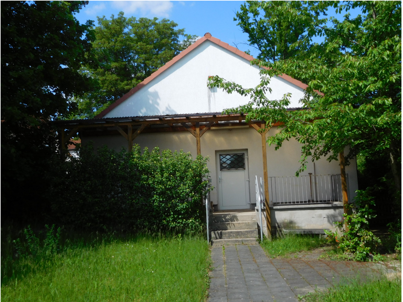
Ansicht südlicher Eingang
