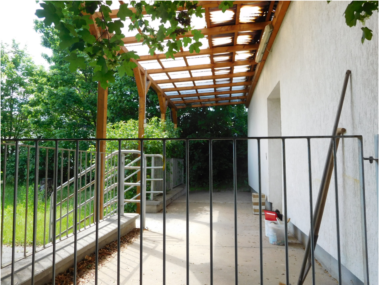
Ansicht südlicher Eingang mit Terrasse
