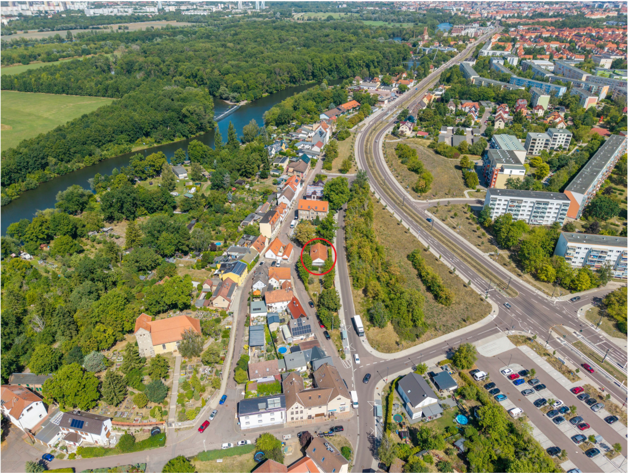
Luftbild mit markiertem Gebäude © Stadt Halle (Saale) - Pressestelle - 2026
