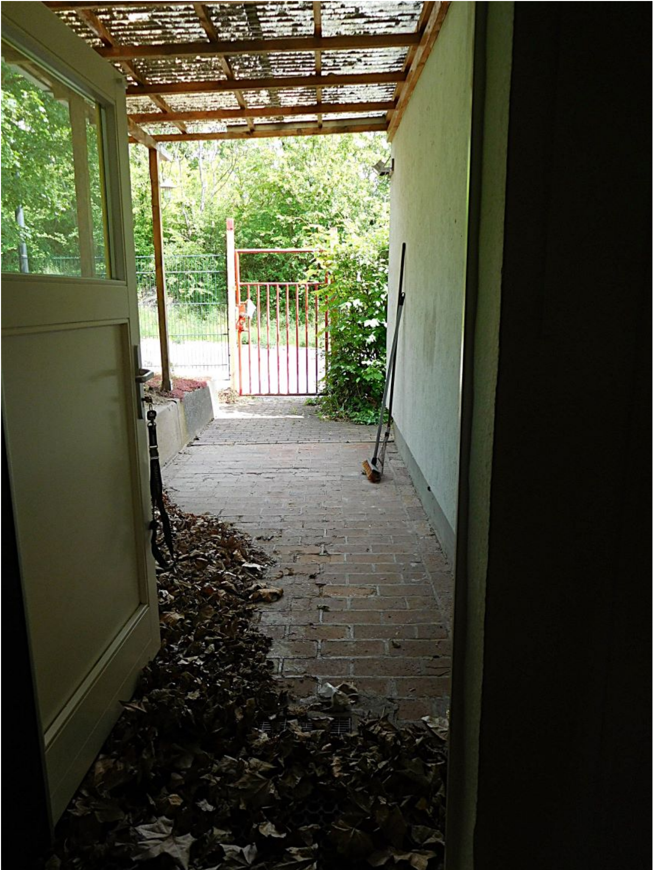
Nordöstlicher Eingang Gartentür
