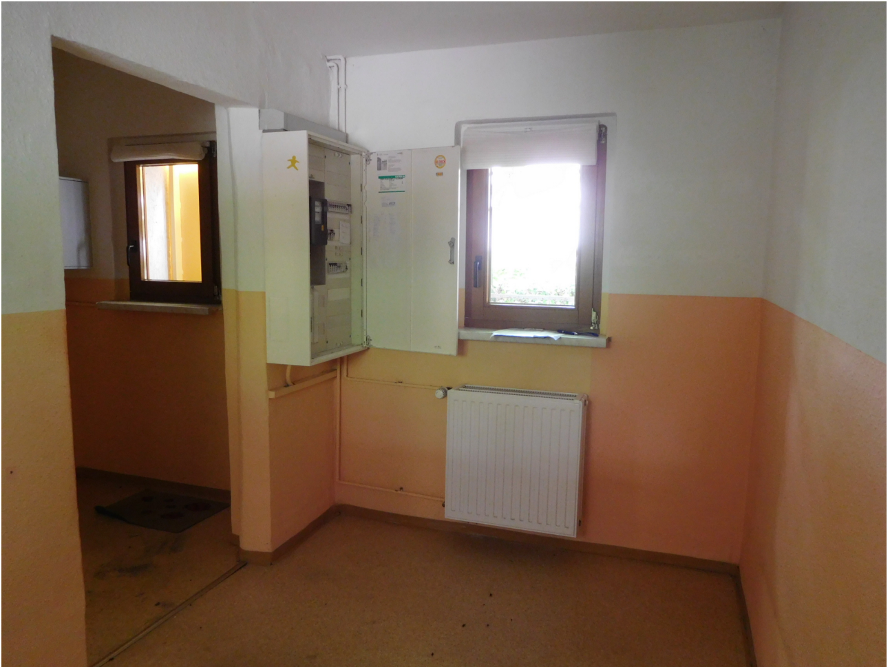
Nebenraum, nordöstlicher Eingangsbereich
