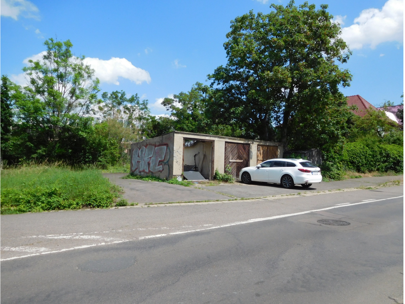
Straßenansicht von Südwesten
