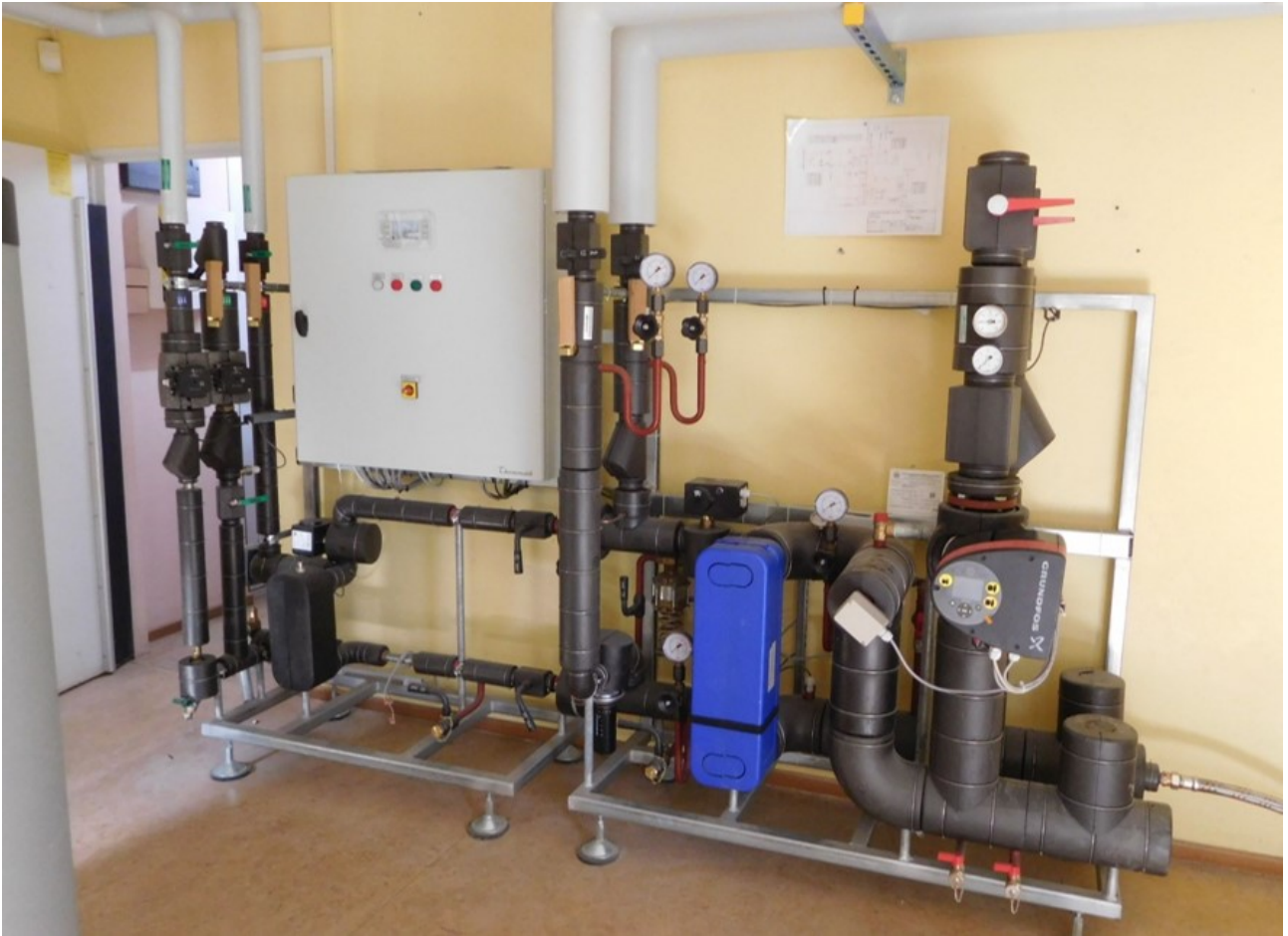
Fernwärme-Kompaktstation
